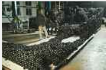
fig.11 大量の球体による施工の様子
